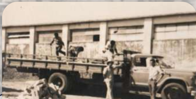
Início da construção do Hospital Dom Orione
